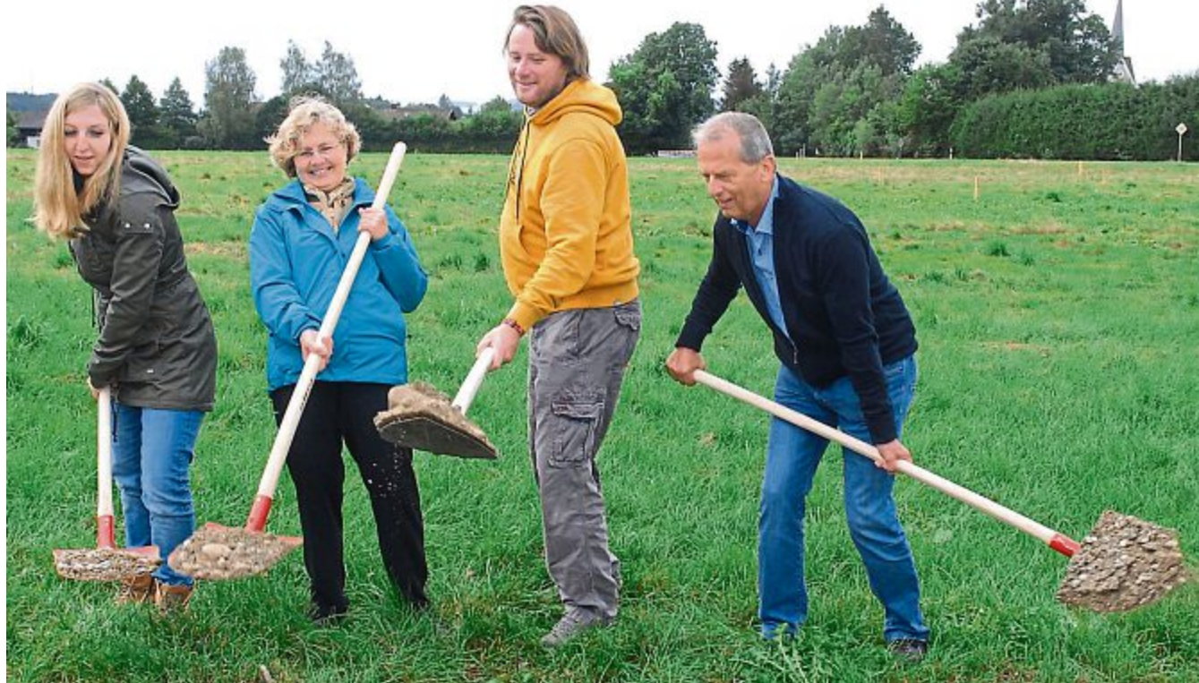
Es kann losgehen: (v. li.) Bauamtsleiterin Elisabeth Schelle, Bürgermeisterin Leni Gröbmaier, Planer Jürgen Eichhammer und Bauleiter Wilhelm Peter tätigten den symbolischen ersten Spatenstich fürs Gewerbegebiet Ascholding. FOTO: PEN
