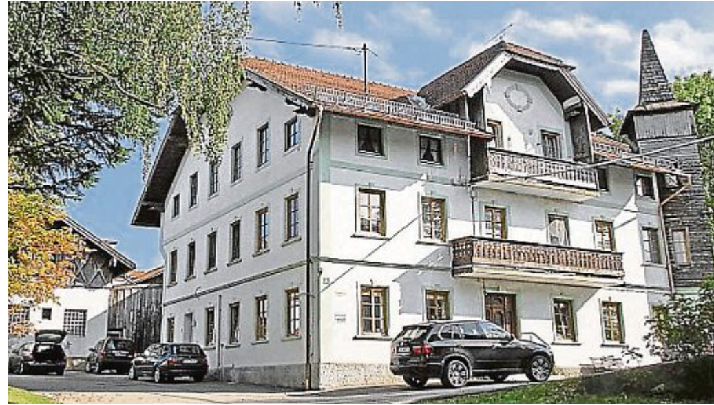
Auch eine Möglichkeit: Ein Verwaltungsgebäude der Firma Wiedenbauer könnte, wenn alles gut geht, kurzfristig bezugsfertig sein.
