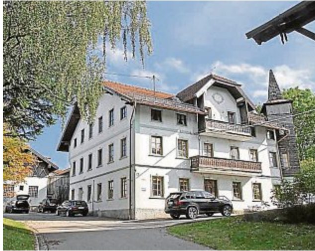
Im ehemaligen Verwaltungstrakt der Bonbonfabrik Wiedenbauer sollen Flüchtlinge eine Bleibe finden. FOTO:SH
